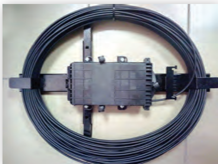
Рис. 4. Кабель со свободным буфером, заведенный в оконечную коробку
