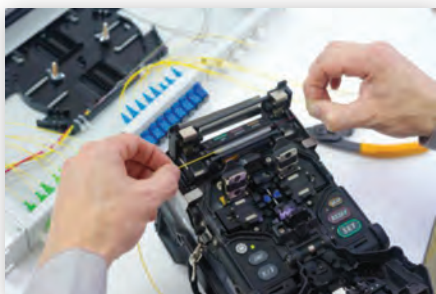
Рис. 5. Сварка магистрального и оконечного волокон
