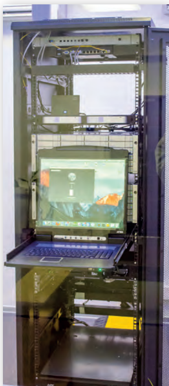
Система хранения Promise VTrak, установленная в специальном помещении со стабильным микроклиматом
